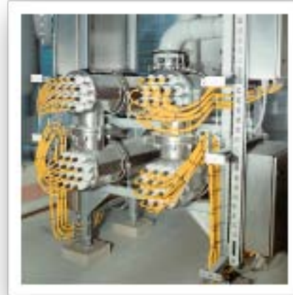
Agua ultra purificada
